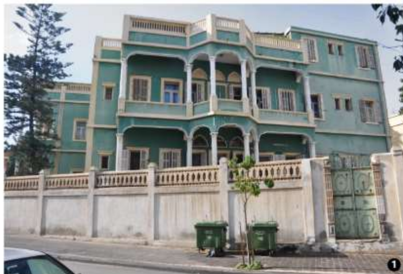
תיאור המבנה מבנה בן שתי קומות מעל קומת מסד, וכן קומת גג חלקית. שטח המבנה: 967 מ"ר. בחצר נמצא מבנה שירות בן קומה אחת מאבן כורכר. נבנה בשנת 1935 עבור שייח' עלי אבו סעיד כבית ליחואן מודרני. משמש מגודר לפי תכנית 2551 כמבנה לשימור. משמש כיום את בית הדין הצבאי.
